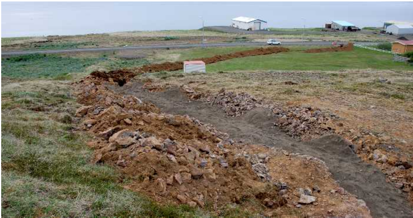
Mynd 44 Framkvæmdir á lögnum á Bakkafirði
